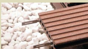
Abbildung zeigt wie der Stoßverbinder bis zum Anschlag in die Dielen gesteckt werden. Danach werden die Verbinder durch die Nut verschraubt.
