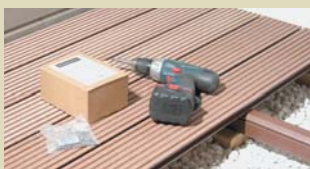
Giunti di dilatazione realizzati sulla copertura, sia frontalmente che lateralmente
