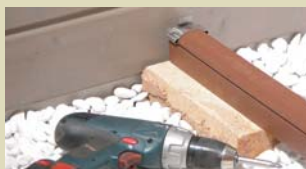
Clip iniziale/terminale montata su un travetto 60 x 50
