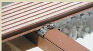
Primo listone inserito nella clip iniziale e clip sagomata già fissata per il montaggio del secondo listone
