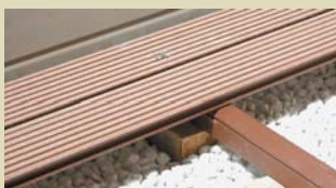
Secondo listone inserito con una distanza di 8 mm tra i listoni.
